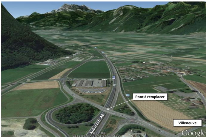
Figure 7. Situation du pont à remplacer
