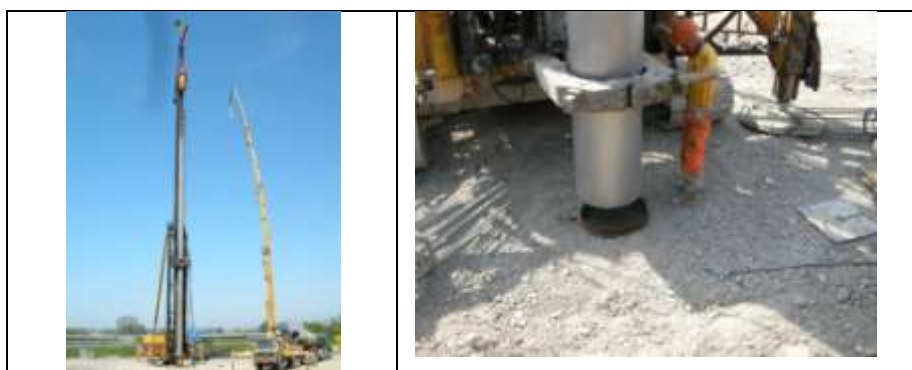
Figure 3: mise en place d'un pieu de type Vibrex (gauche : fonçage, droite : sabot de pieux)
