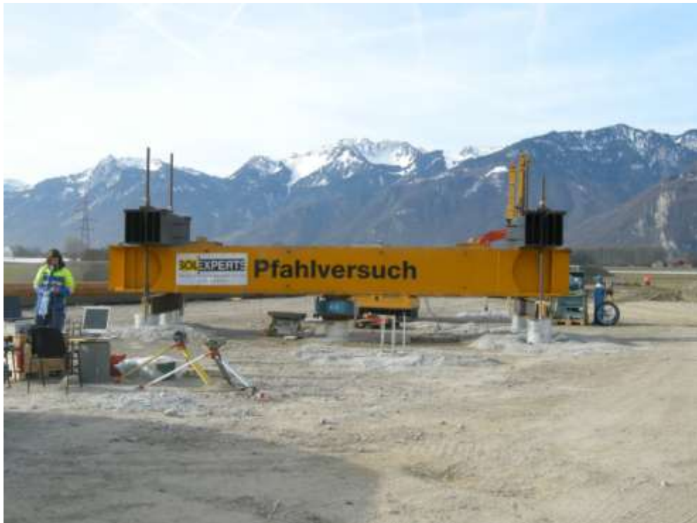
Figure 5: photo de l'essai de pieu
